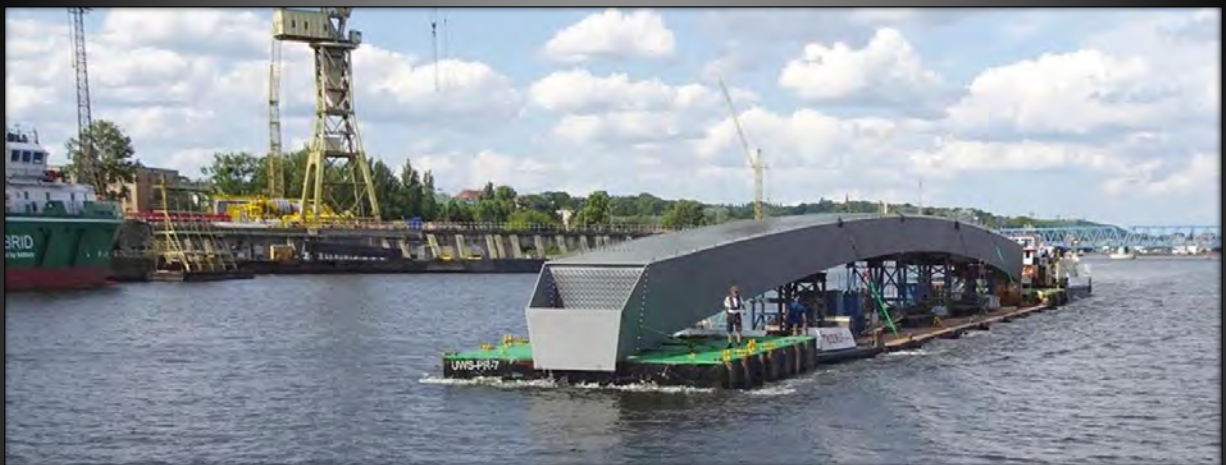
Transport eines Brückensegments von Stettin nach Liepe Schwertransport
