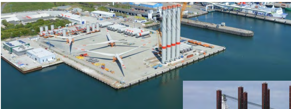
(48a) Vormontage von Windkraftanlagen für die Ostsee in Mukran/Rügen
