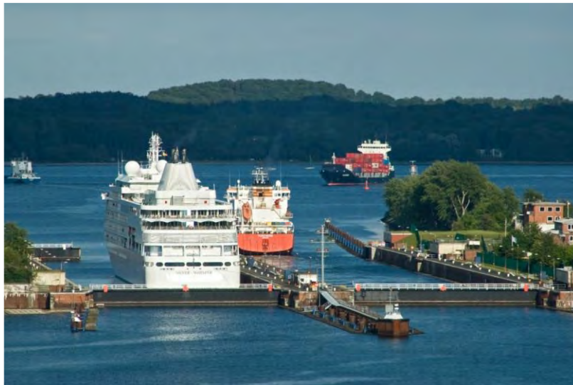
(6) Nord-Ostsee-Kanal - Schleusen Kiel-Holtenau - Schiffe bei Ein-/Ausfahrt – z.B. mittelgroße Kreuzfahrtschiffe / Höhe max. 40 m
