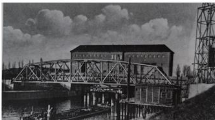
Zwillingschachtschleuse Eisenhüttenstadt zur Anbindung an Berlin; Inbetriebnahme 1929
