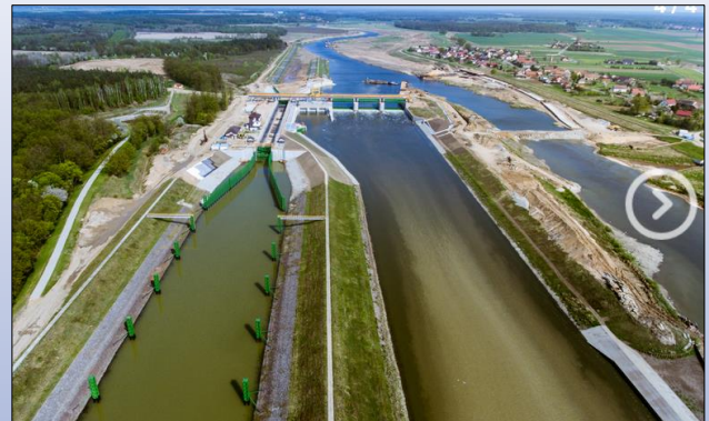
Staustufe Malczyce (Bauzustand 2018)
